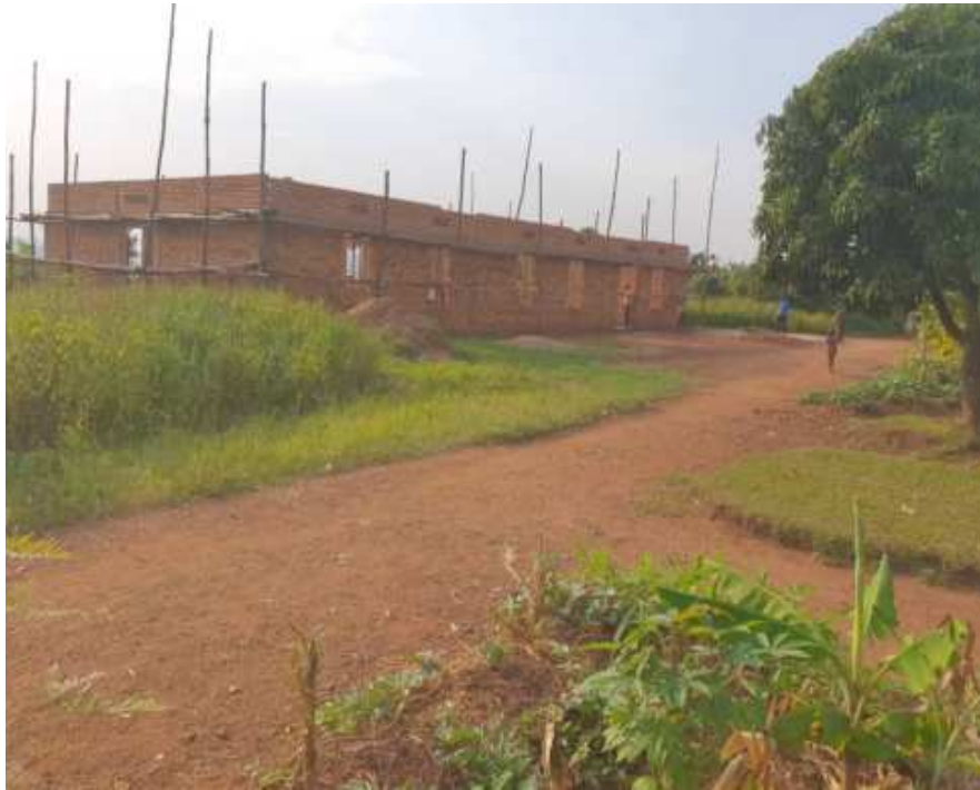
De bouw van de Rujambara tempel tijdens het leggen van de fundering en de muren
