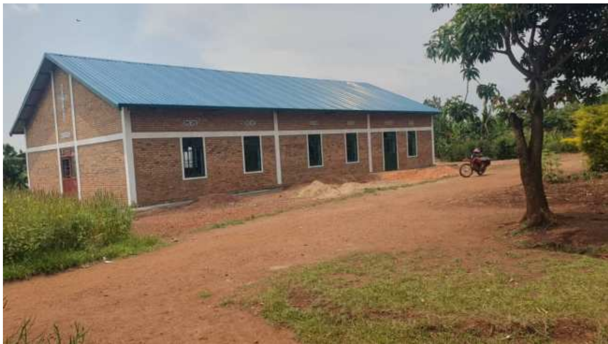
De afwerking gaat door nadat het dak erop zit en de gelovigen hebben aangegeven dat ze steun nodig hebben.
